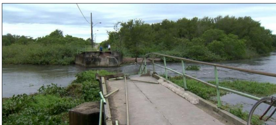
Figura 8 - Ponte da Madalena 2017 Fonte: https://globoplay.globo.com/v/6332006/
