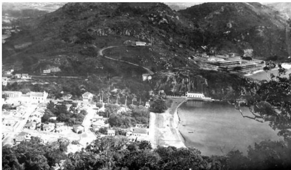
Figura 8. Prainha na década de 1950. Ao fundo, à direita, a construção da sede da EAMES.
