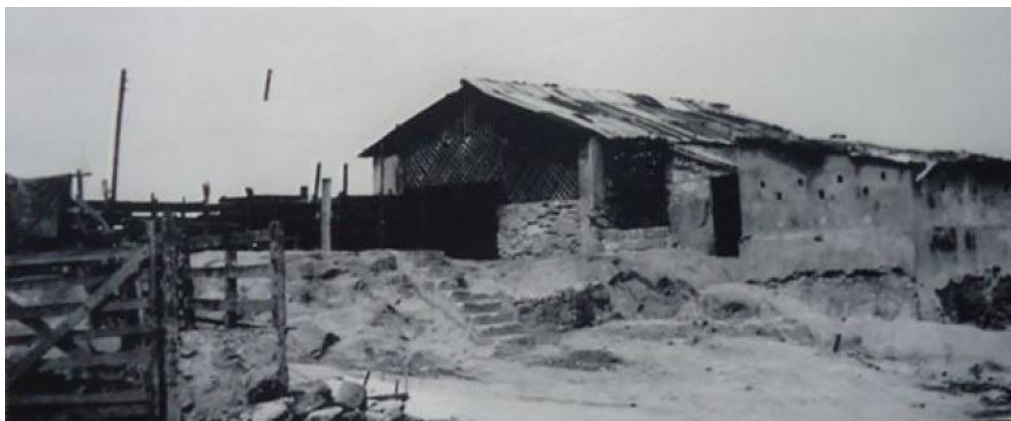
Figura 9. Antigo Matadouro Municipal de Vila Velha, ES. Década de 1950.
