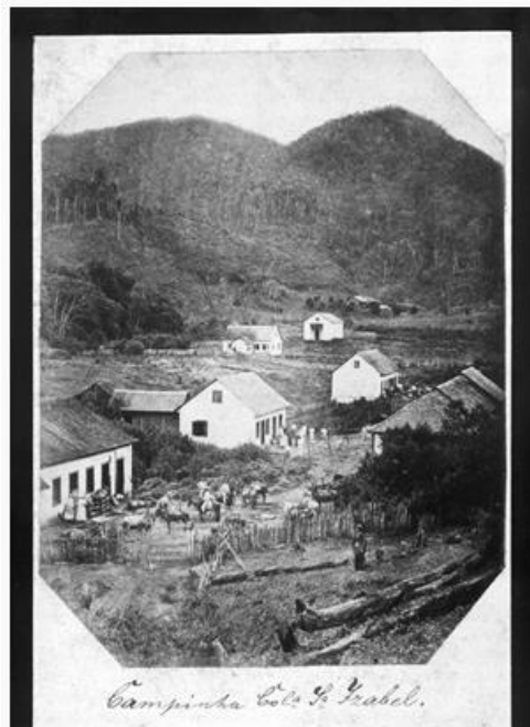
Figura 26: Construção da capela escola e da casa pastoral por colonos alemães em campinho, Espírito Santo.
