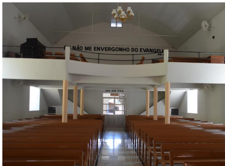
Figura 38: Atual coro da paróquia de Jequitibá, construído após a queda do coro de madeira.
