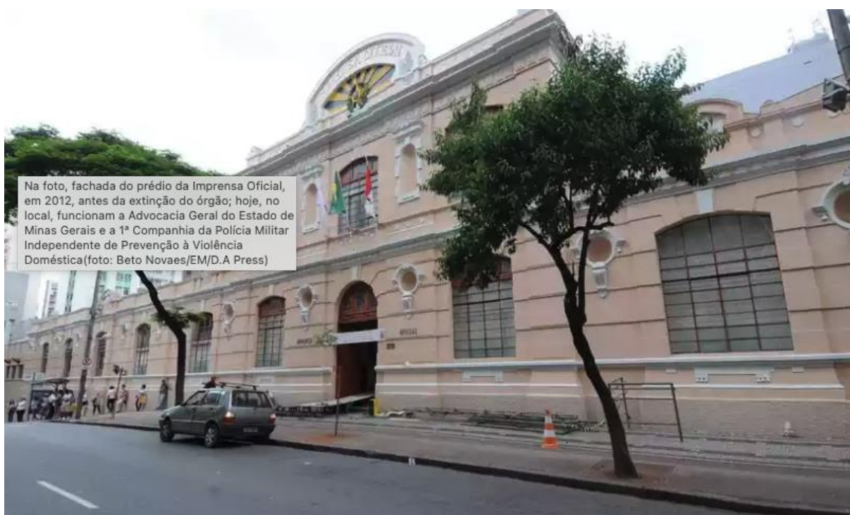
Figura 7: Foto da fachada da extinta Imprensa Oficial.
