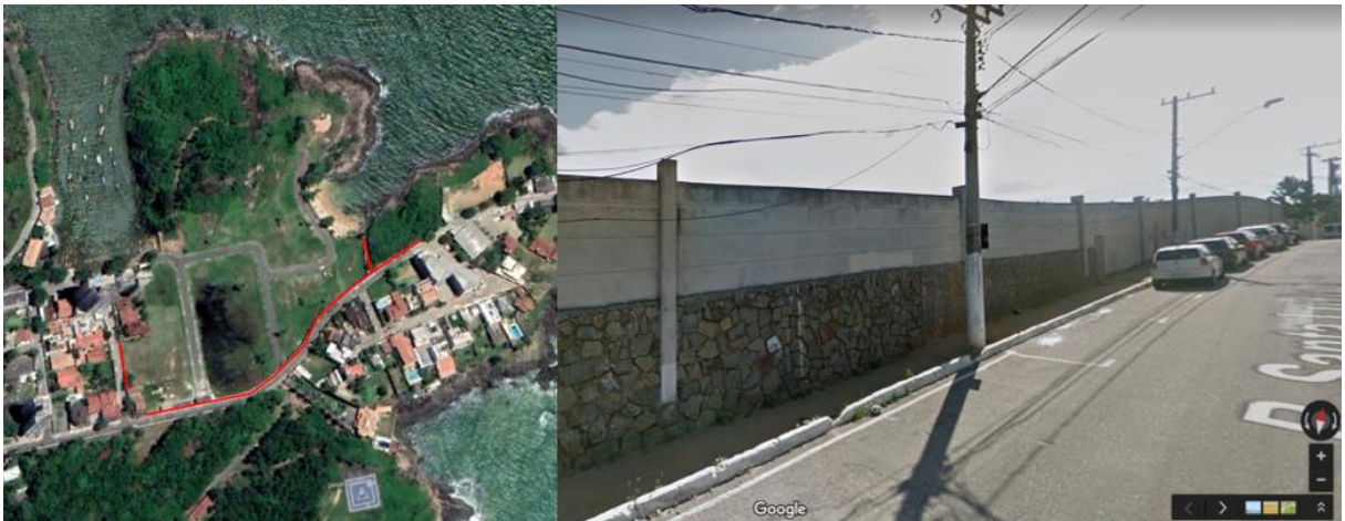
Figura 7. Muro de loteamento fechado em Vila Velha dificultando o acesso à praia.
