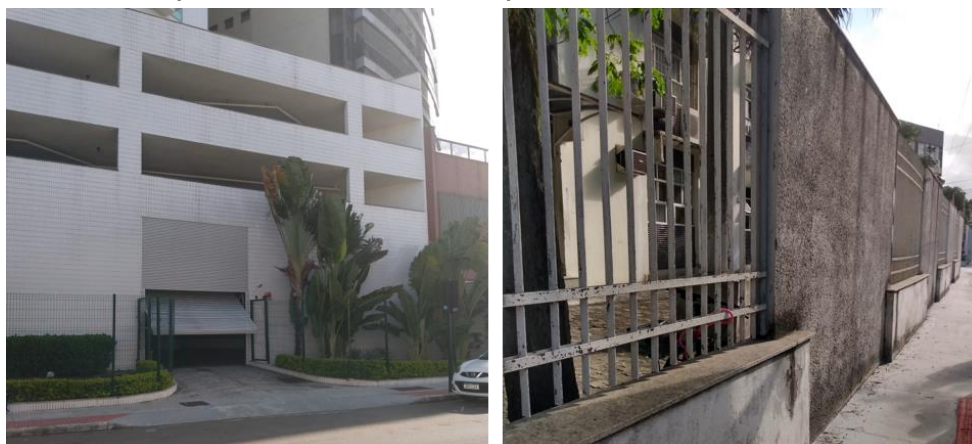
Figura 37. Exemplos de fachadas introspectivas encontradas na rua estudada.
