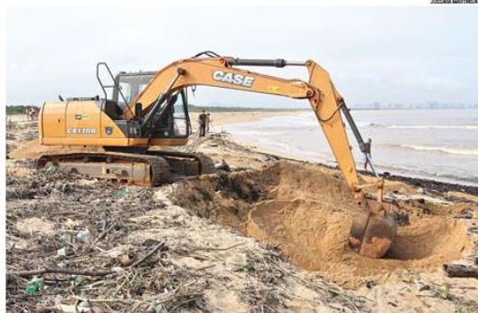
MAQUINA é usada pela Prefeitura de Vila Velha para abrir área de escoamento do Rio Jucu, na Barragem do Jucu.
