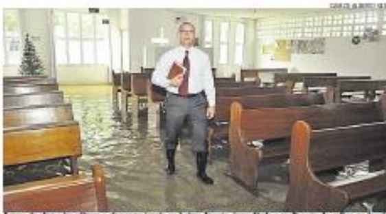
Água da chuva se alastra e alagou igreja no bairro Araçá, impedindo a realização de culto no local.
