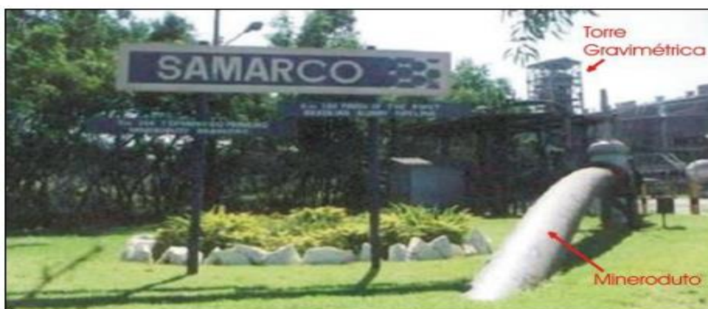
Figura 5– Chegada do Mineroduto de Mariana – MG à Usina de Ubu, localizada em Anchieta - ES
