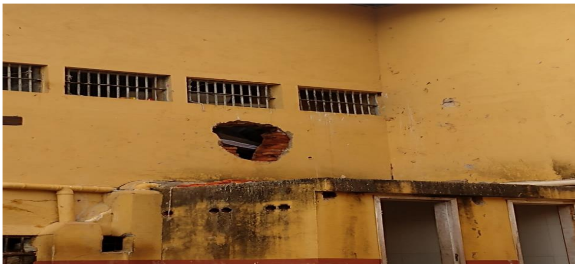
Figura 12: local utilizado pela equipe da DOT para acesso ao pátio da unidade
