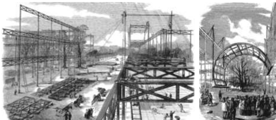
Figura 80: Construção do Crystal Palace, para a Exposição Universal de 1851, em Londres.
