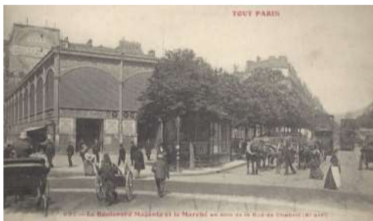
Figura 72: Fotografia do mercado Saint-Quentin, construído em 1866, na região onde era realizada a Feira Saint-Laurent, em Paris.
