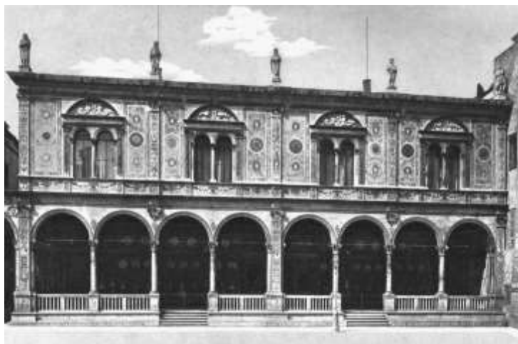
Figura 50: Fachada da Loggia del Consiglio, na Piazza dei Signori, em Verona.
