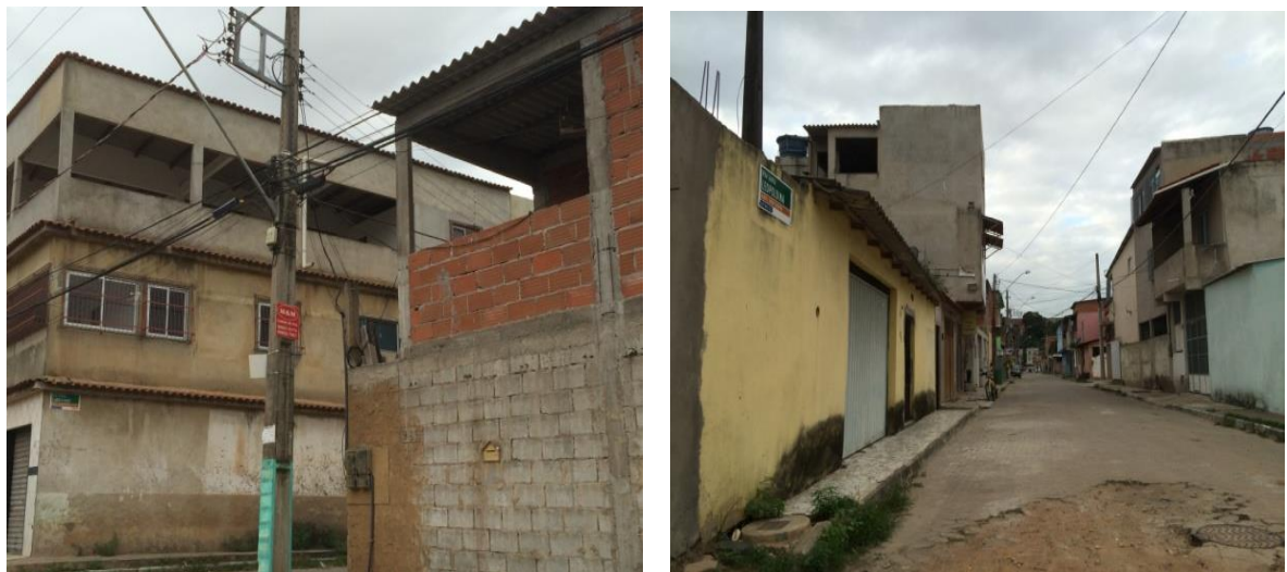
Figura 28 – Fotografia de Jardim Carapina – Fiação Rede Elétrica Desordenada.
