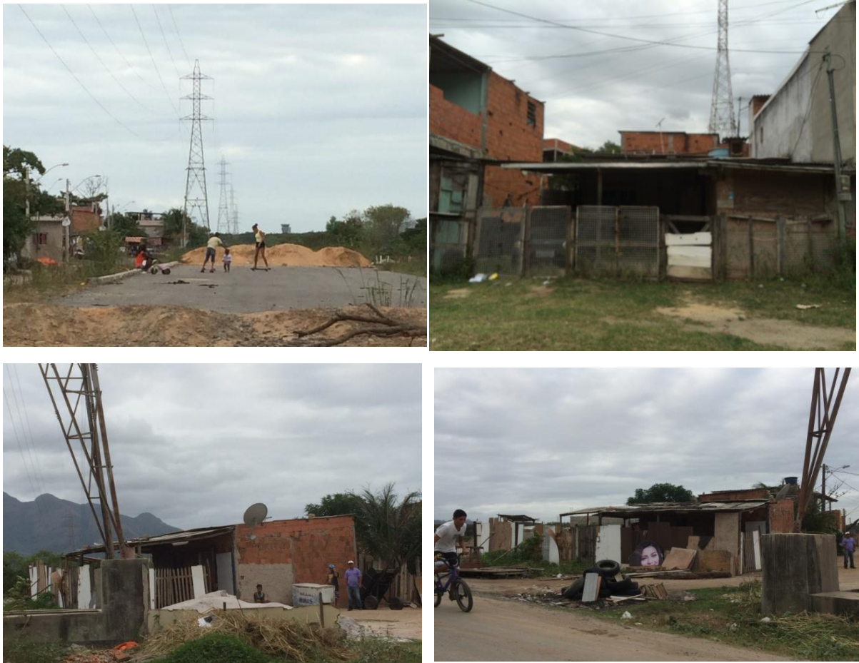
Figura 29 - Fotografia de Jardim Carapina – Torres de Alta Tensão Próximas as Habitações.
