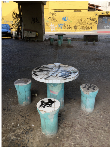
Figura 6: mobiliário urbano com pouca manutenção
