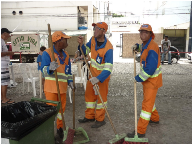
Figura 42: limpeza pública durante a terceira intervenção urbana.
