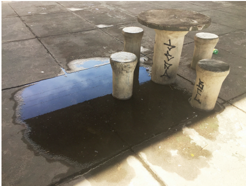
Figura 26: mesas e bancos de cimento degradados embaixo da Terceira Ponte.
