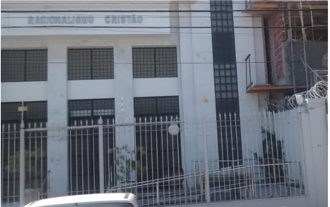
FIGURA 08- Combinação de lanças, cerca elétrica e concertina em Igreja do bairro Bento Ferreira
