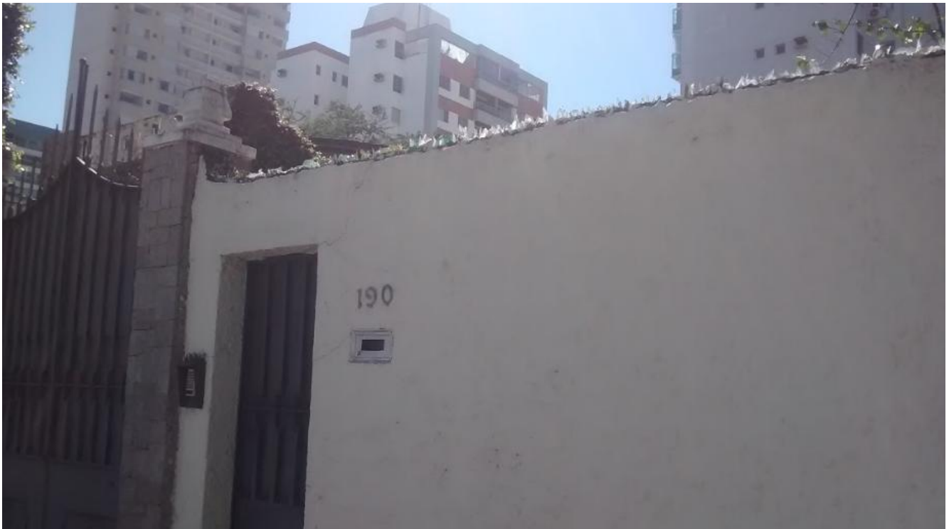
FIGURA 07 – Muro com cacos de vidro em uma residência do bairro Bento Ferreira
