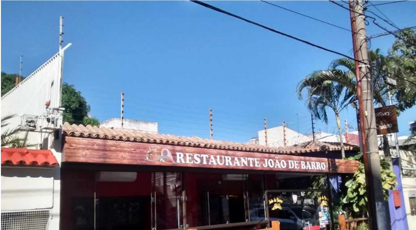
FIGURA 06 – Cerca elétrica e sistema de vídeo monitoramento
