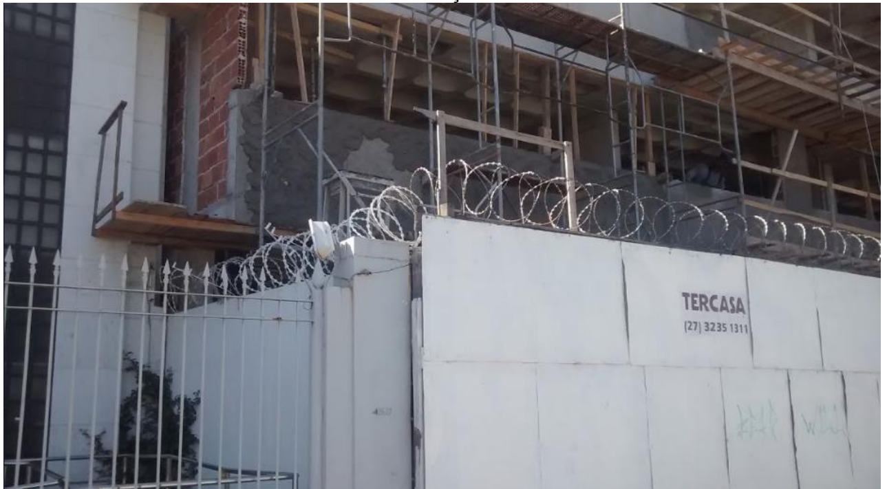
FIGURA 05: Concertina em construção no bairro Bento Ferreira
