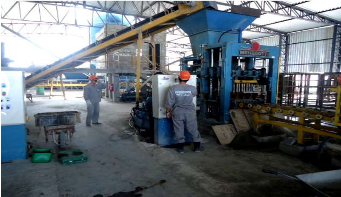
Figura 45. Fábrica de Pré-moldados/AL. Fonte: Alagoas (2015).
