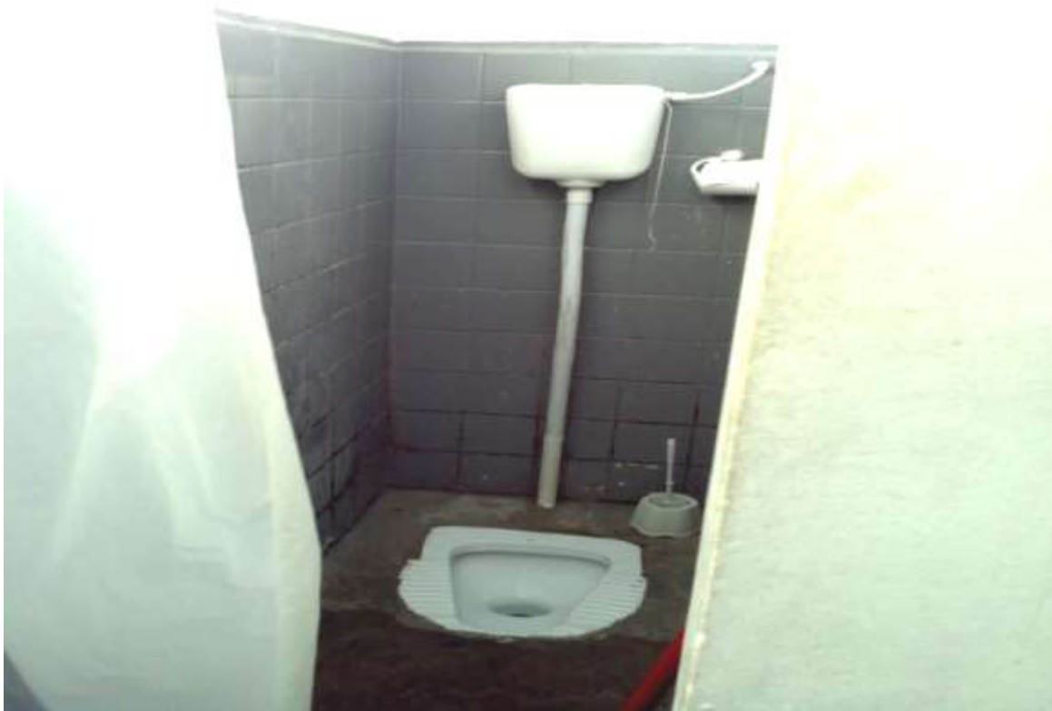
Figura 36. Banheiro de cela NRC/AL.
