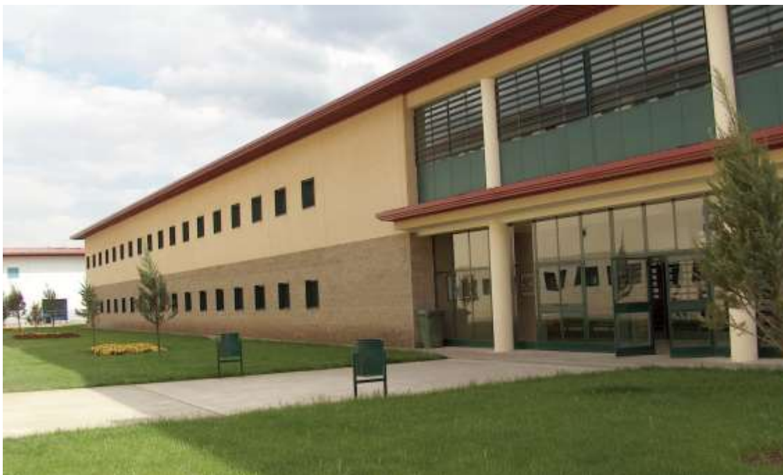
Figura 20. Módulo de Respeito de León/Espanha Fonte: Espanha (2014, on-line).
