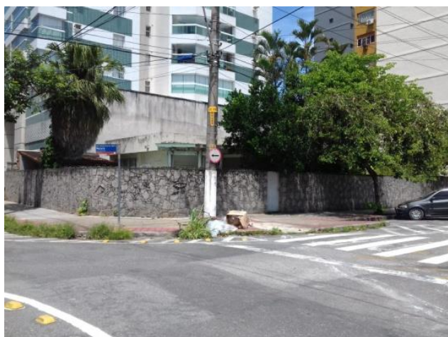
Figura A83. Casa de esquina abandonada Fonte: Acervo do autor.
