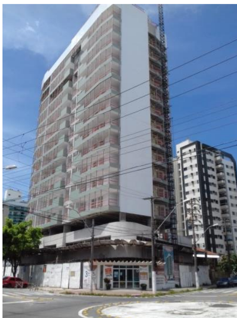
Figura A82. Prédio em obras Fonte: Acervo do autor.
