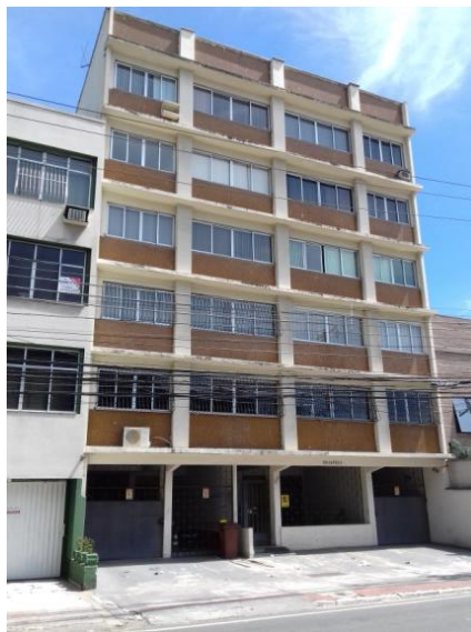
Figura A27. Edifício Capela Fonte: Acervo do autor.
