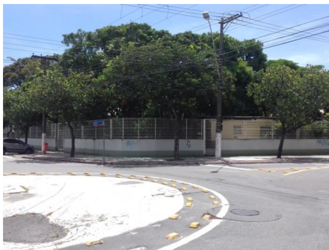
Figura A96. Esquina fundos centro de treinamento Fonte: Acervo do autor.
