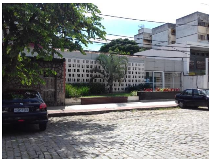
Figura 33. Casa do Arquiteto (B) Fonte: Acervo do autor.
