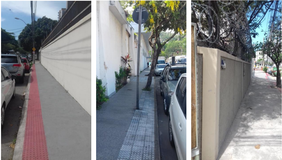
Figura 14. Muros elevados no Bairro Bento ferreira Fonte: acervo do autor.
