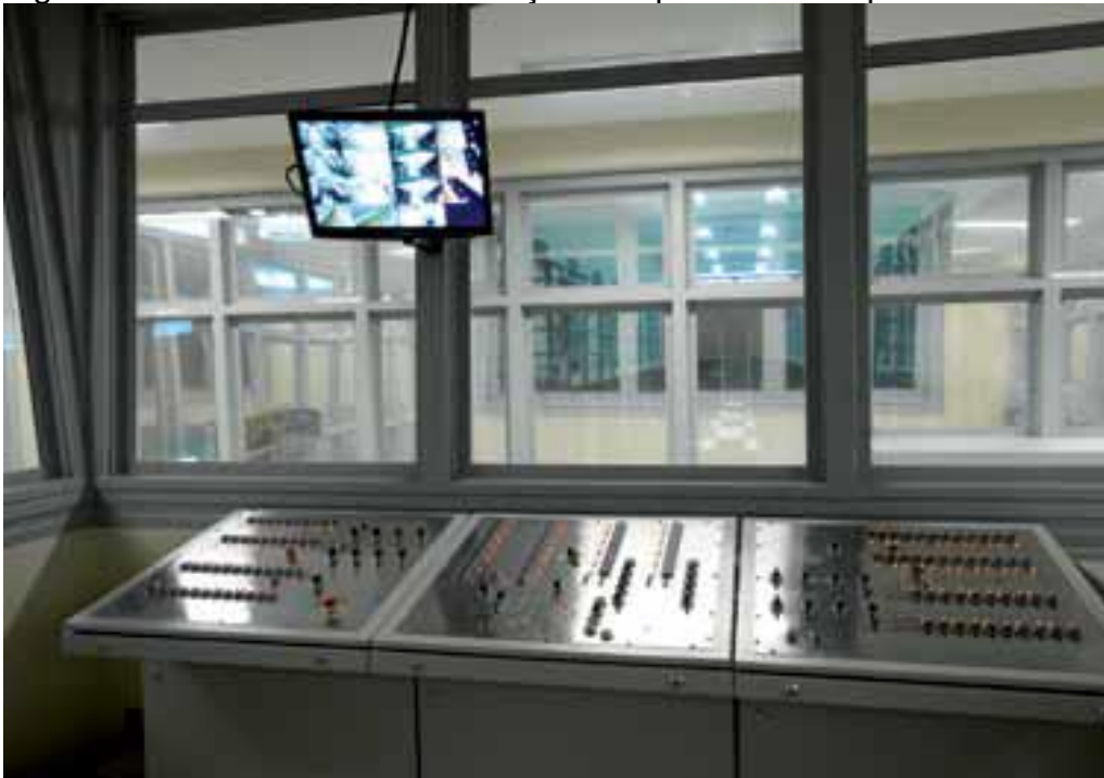
Figura 8 – Sistema de automatização das portas de um presídio
