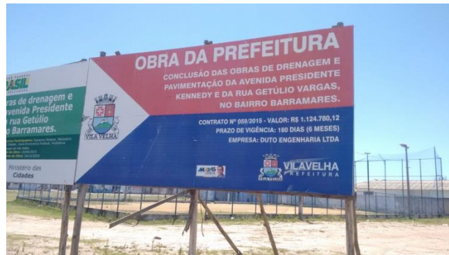
Foto 2 - Placa de conclusão de drenagem e pavimentação – Bairro Barramares
