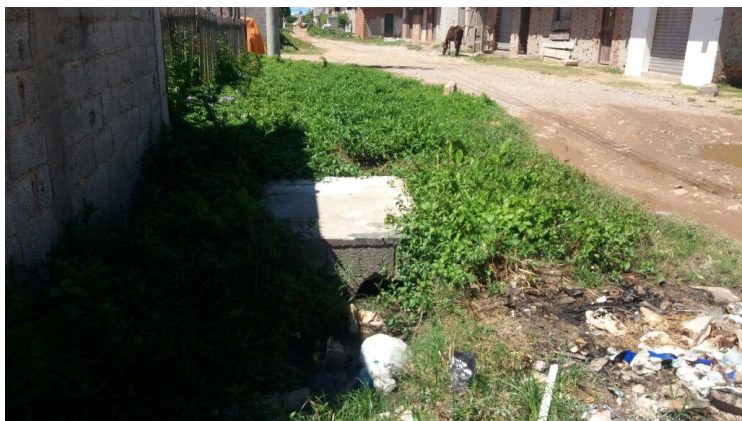
Foto 22 – Rua Getúlio Vargas que recebeu a conclusão da obra
