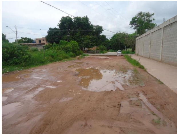
Foto 13 – Rua Rio de Janeiro – bairro Morada da Barra
