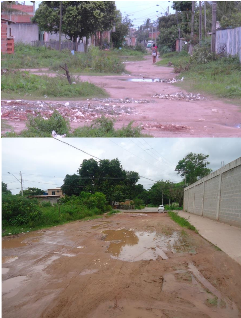
Foto 18 - Rua Rio de Janeiro – bairro Morada da Barra
