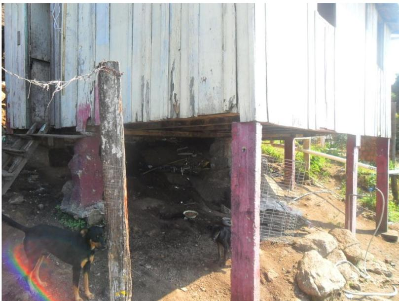
Figura 5 casa construída em madeira, sendo que a sua estrutura está alicerçada na pedra, com sustento em madeira, 2012 Fonte: PMV- Arquivo da Regional 14
