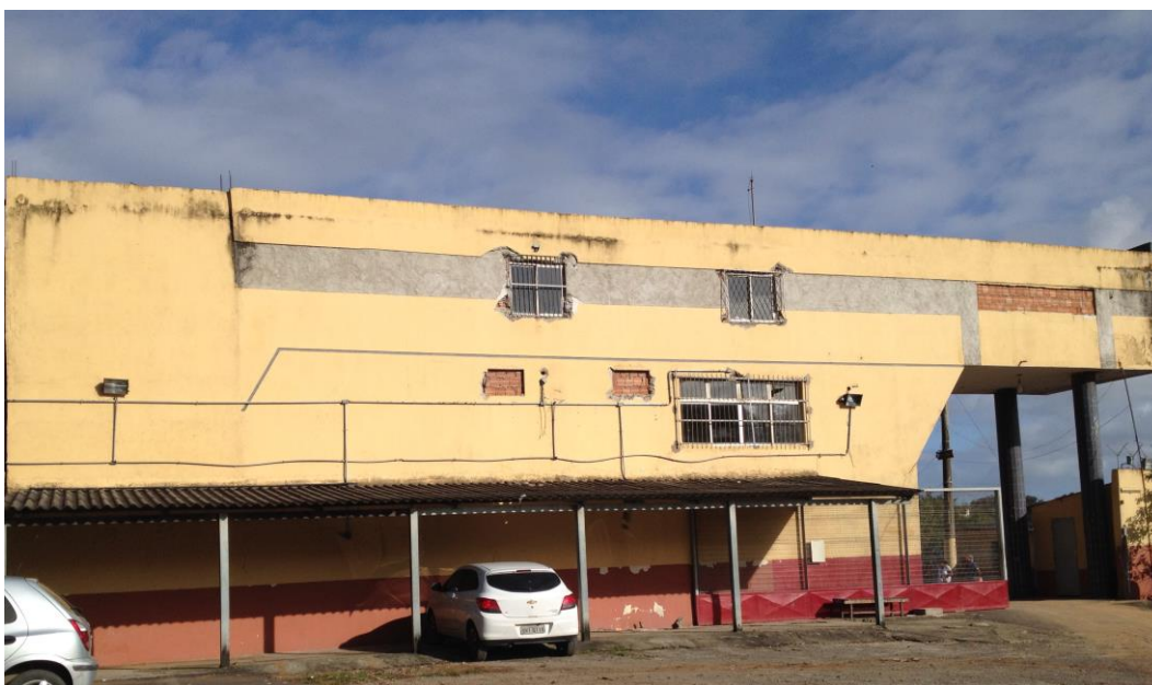
Foto 5 – Vista principal da Cascuvv
