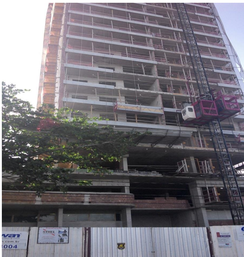
Figura 17 – Obra da Galwan Construtora Fonte: Arquivo Pessoal
