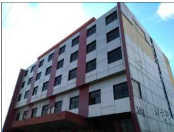
Figura 14 - Edificação abandonada. Av. Nossa Senhora dos Navegantes
