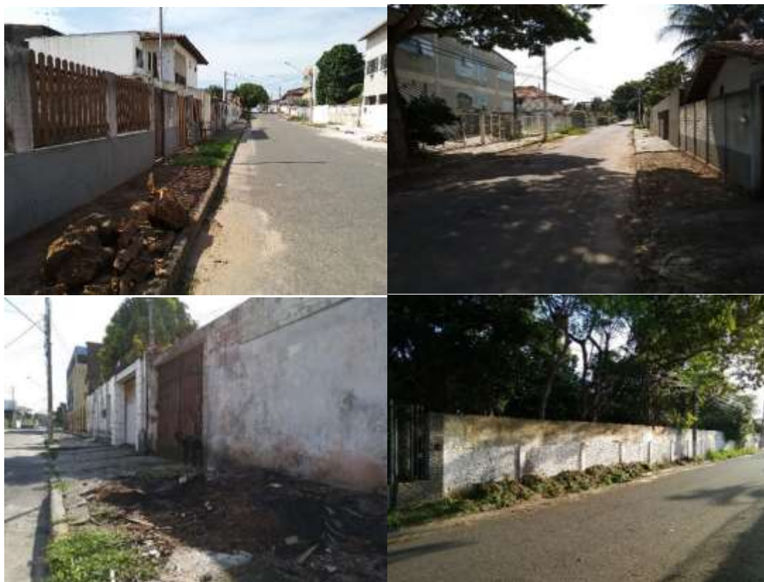
Figura 10 - Condições das calçadas na região de Jacaraípe
