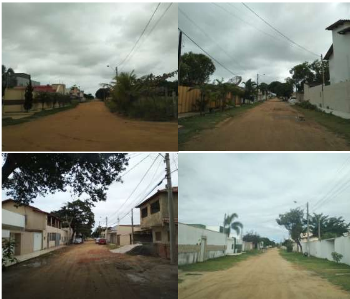
Figura 14 - Registro fotográfico de áreas sem pavimentação de Guriri
