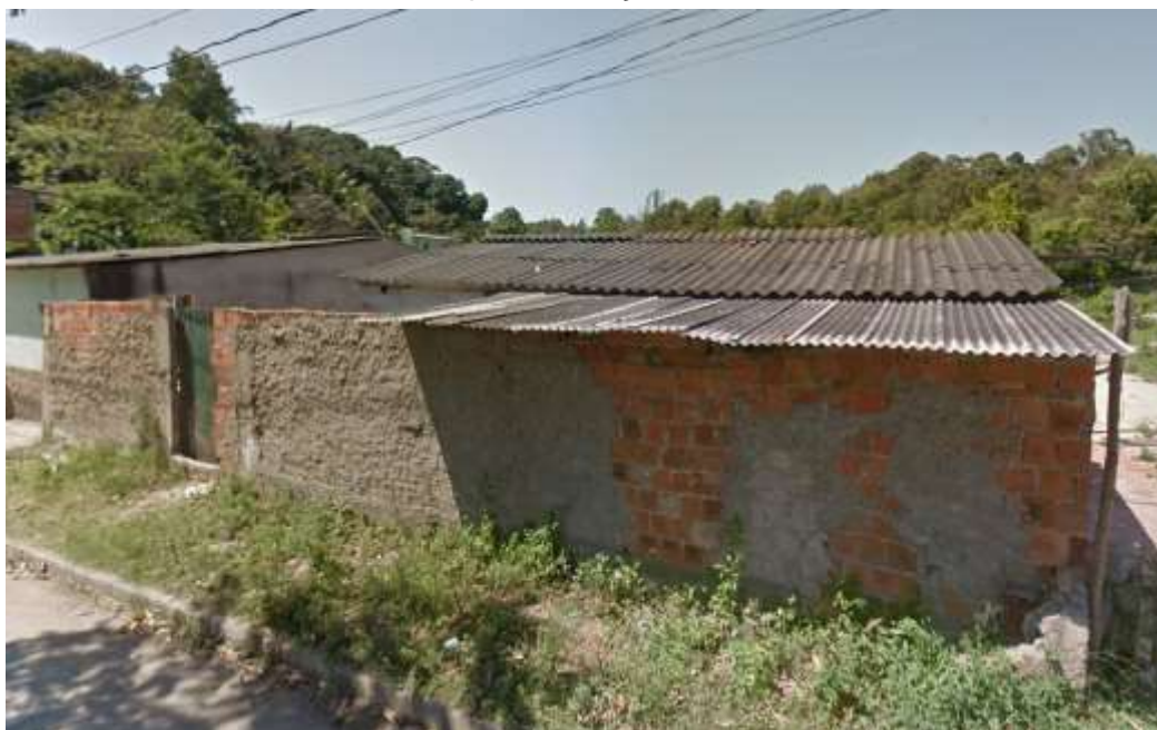
Figura 12 - Área sul do bairro sem pavimentação
