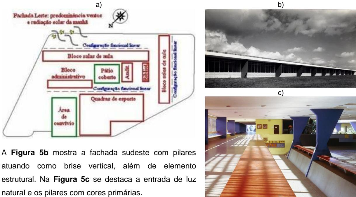
A **Figura 5b** mostra a fachada sudeste com pilares atuando como brise vertical, além de elemento estrutural. Na **Figura 5c** se destaca a entrada de luz natural e os pilares com cores primárias.
