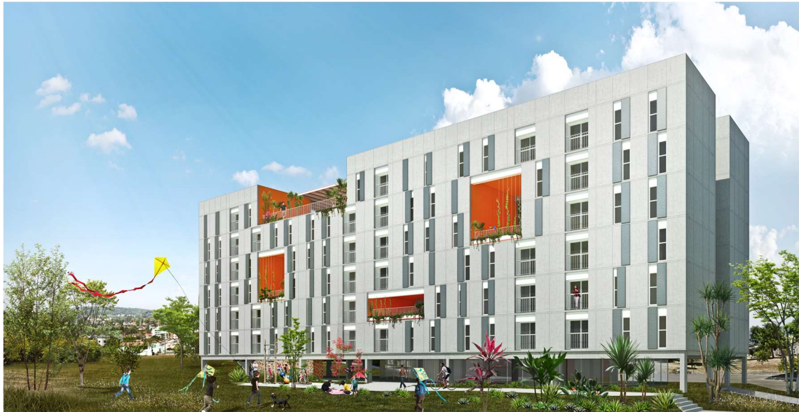
Figura 21 – Fachada e esquema do sistema construtivo sugerido pela proposta da menção honrosa 335 do edital 005/2016.
