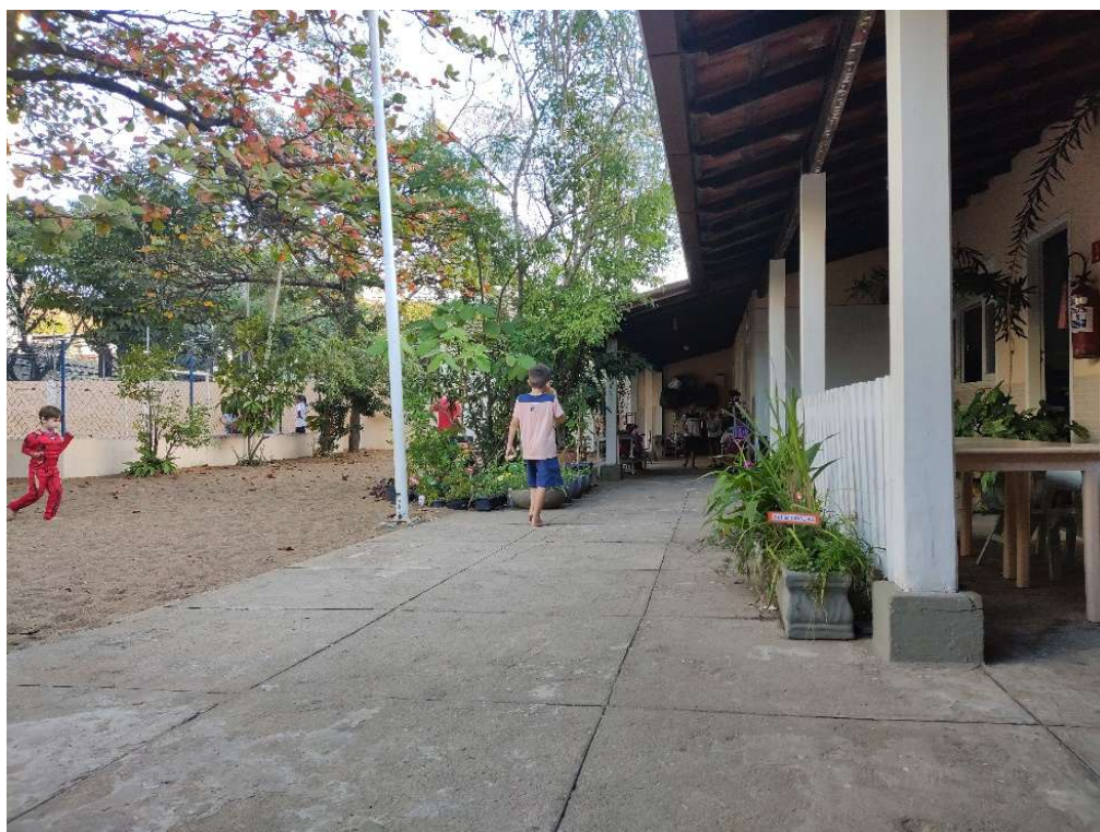
Figura 93 - Cimentício rugoso no piso das calçadas (corredores abertos) da Escola B. Fonte: acervo pessoal (2024).
