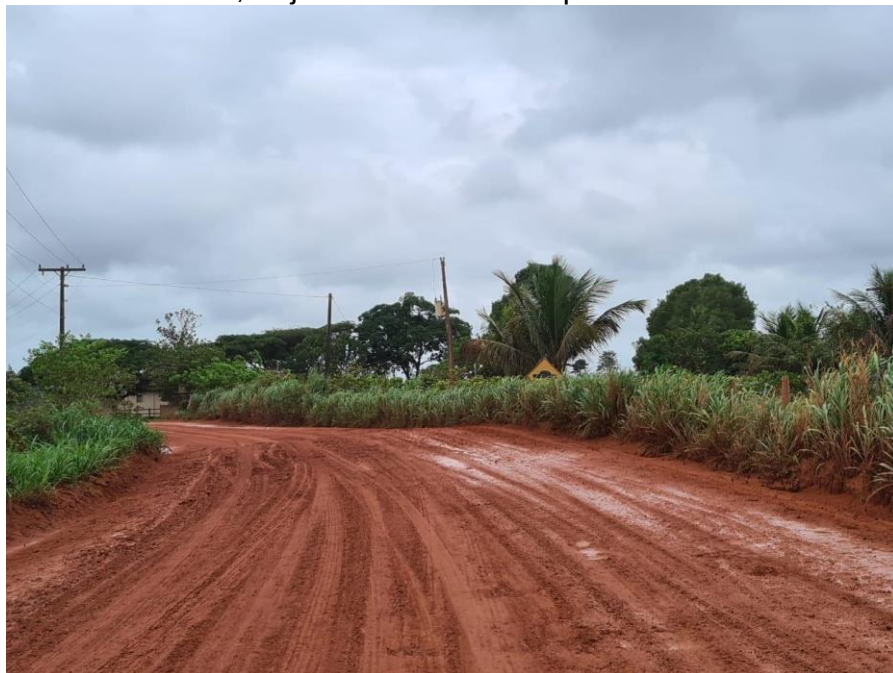
Figura 4. Rodovia ES-440, trajeto não asfaltado que dá acesso à Vila de Regência.
