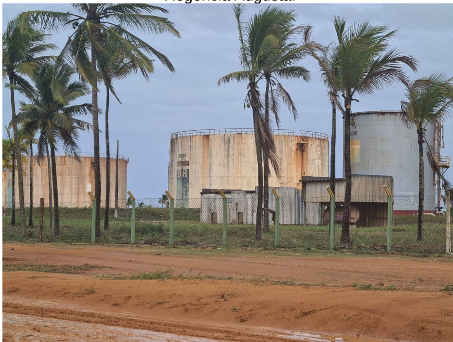
Figura 6. Tambores de processamento de petróleo desativados próximos a Regência Augusta.
