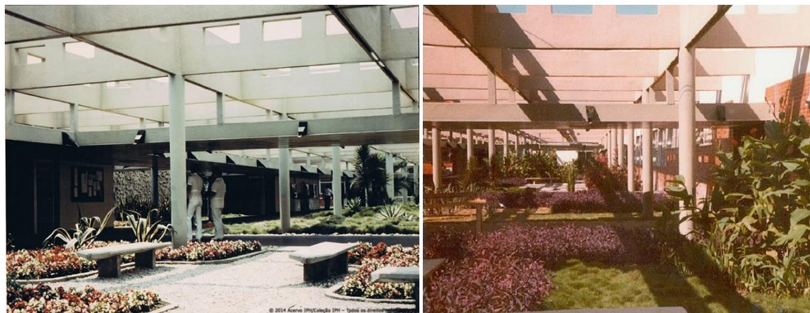
Figura 71: Estrutura modular e espaço interandar do hospital do Galeão.
