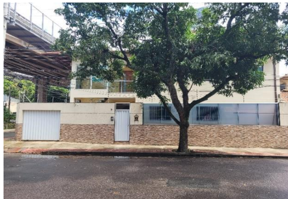
Figura 12. Muro alto, grades, cerca elétrica, portões e interfone
