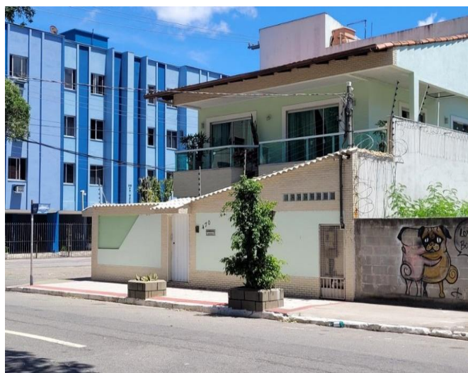
Figura 35. Muro alto, serpentina, sensores e interfone
