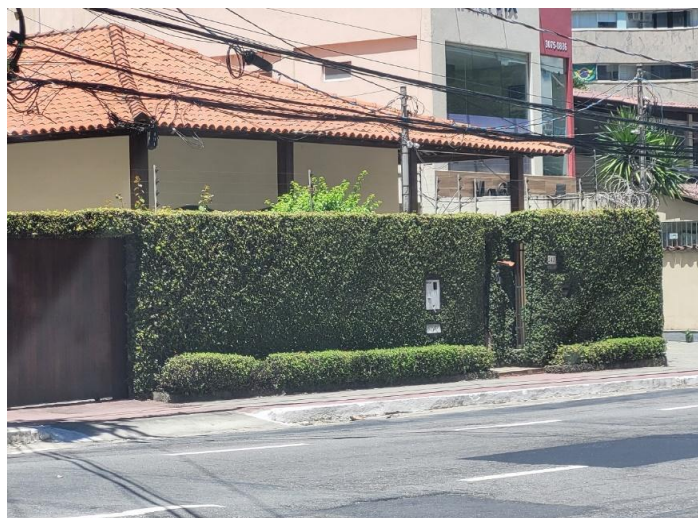
Figura 39. Muro alto, portão compacto, cerca elétrica, serpentina e interfone
