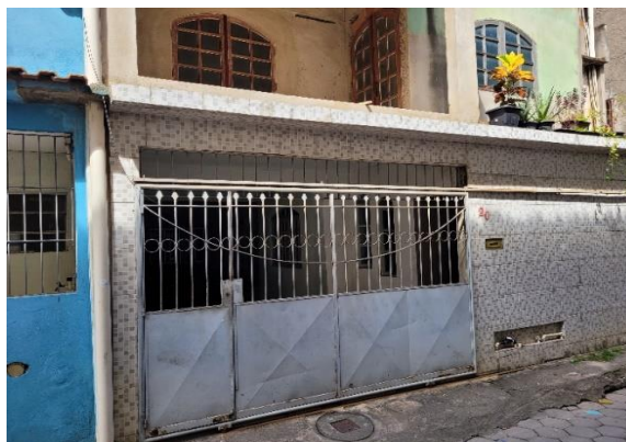
Figura 13. Proteção com grades e lanças
