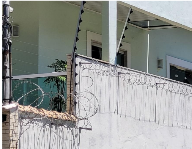
Figura 34. Muro alto, serpentina, cerca elétrica e câmera
