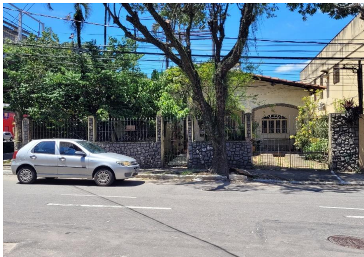
Figura 37. Muro baixo e grade com lanças
