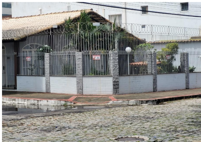
Fotografia 31. Muro, grades com lanças, serpentina e interfone
