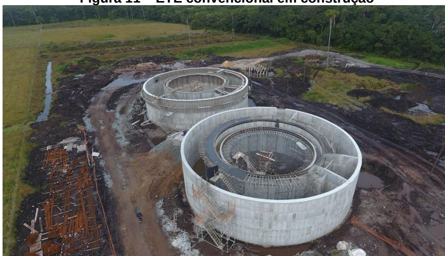
Figura 11 – ETE convencional em construção
