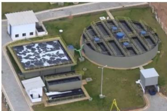
ETE PRONTA EM OPERAÇÃO
