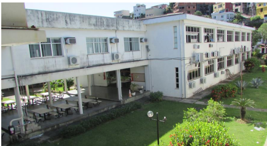
Figura 63 - Edifício do Ifes Campus Vitória: jardim, pátio e biblioteca
