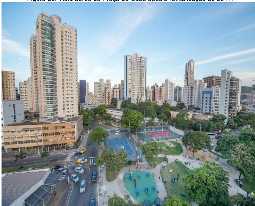
Figura 26: Vista aérea da Praça do Cauê após a revitalização de 2017.
