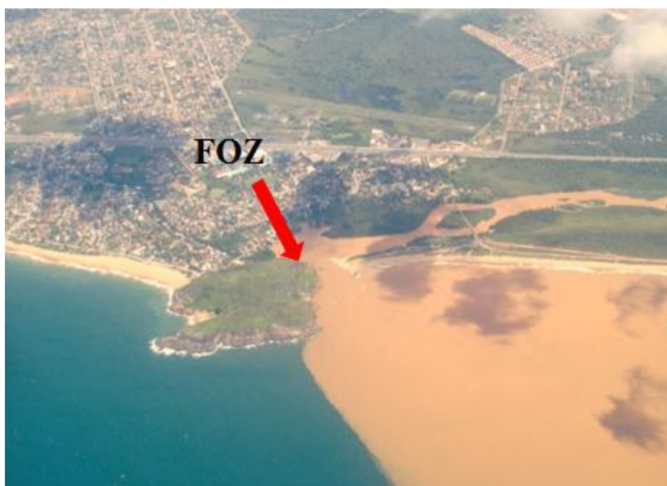
Figura 20- Foz do Rio Jucu em dia de forte vazão
