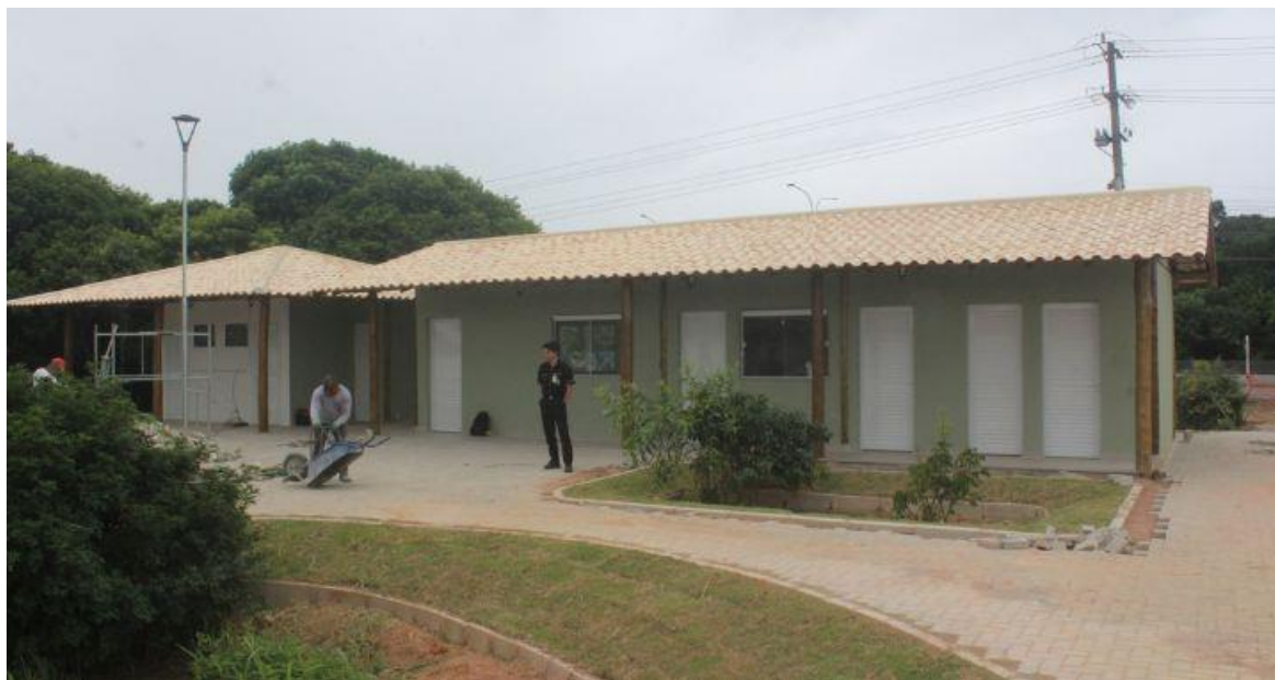
Figura 75- Construção do Centro de Educação Ambiental do Parque Natural Municipal de Jacaranema
