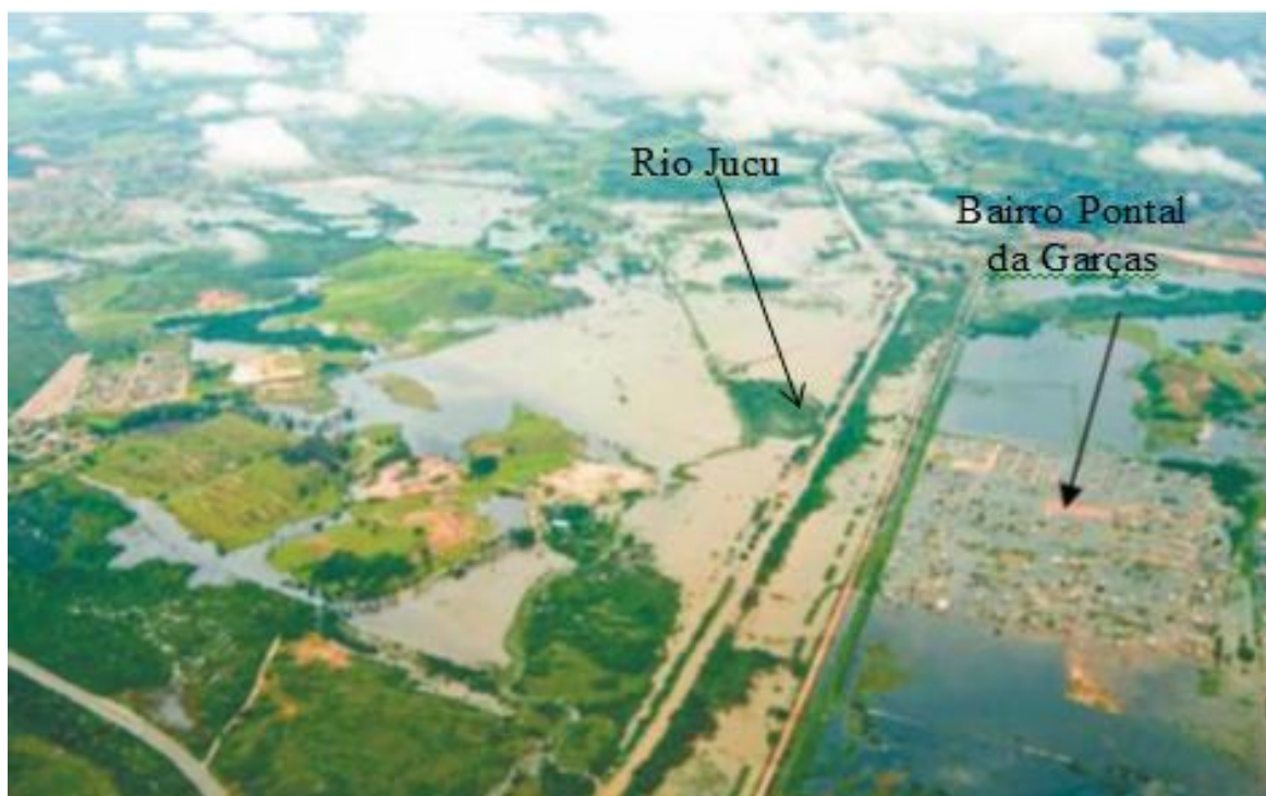
Figura 72- Visão aérea panorâmica do impacto provocado pela ocupação das margens do Rio Jucu na inundação de 2013
