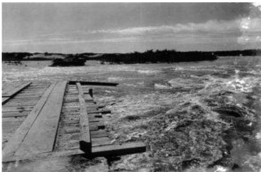
Figura 43- Foto da Ponte Velha do Rio Jucu (atual Ponte da Madalena) na época da enchente de 1960. A ponte foi totalmente carregada pela força da água
