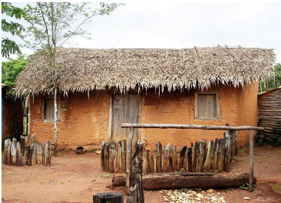
Figura 46- Casa de Estuque coberta por sapê
