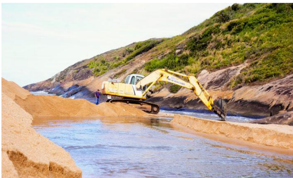
Figura 49- Foz do Rio Jucu obstruída por areia, trator abrindo a foz
