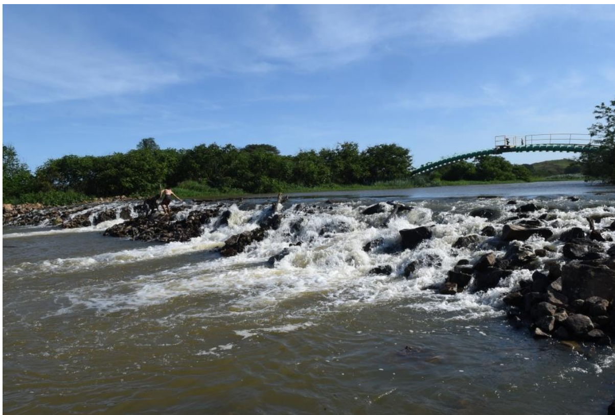
Figura 44- Represa do Rio Jucu, construída pela CESAN, em 1968.
