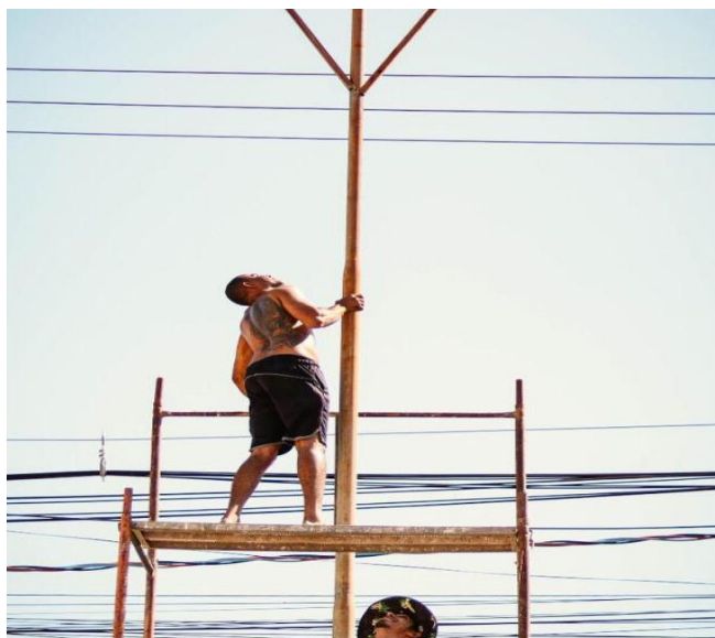
Figura 16: Instalação de Refletores da Quadra. Fonte: VILA DOM JOÃO BATISTA, 2021.
