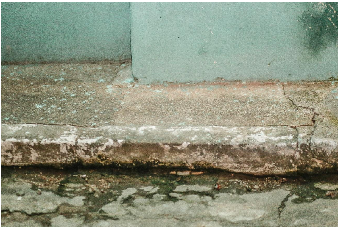
Figura 31: Calçada Rua Paineiras Fonte: Autor, 2023
