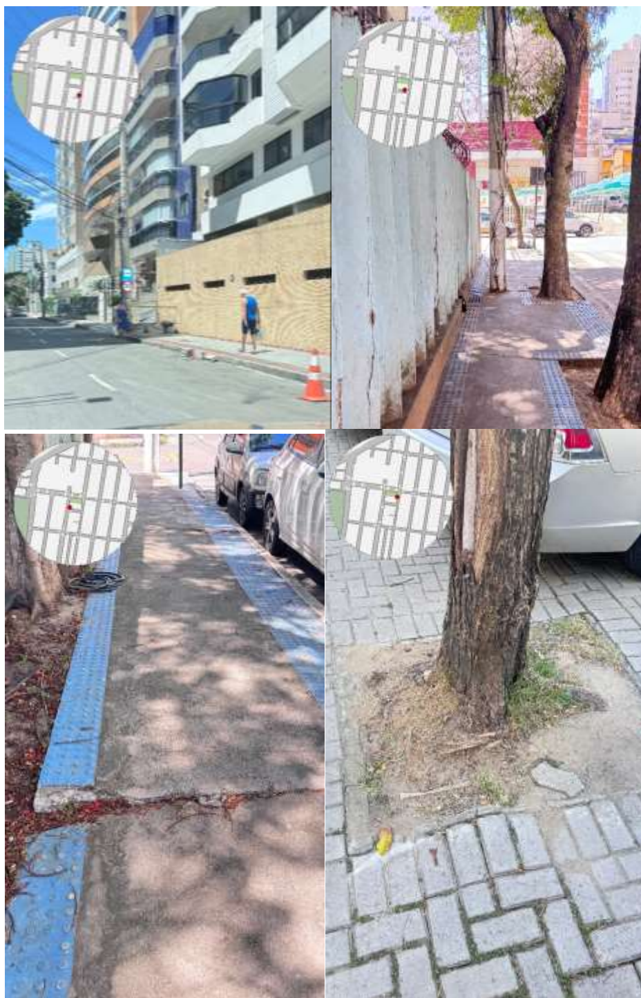
Figura 53: Problemas encontrados nas calçadas
