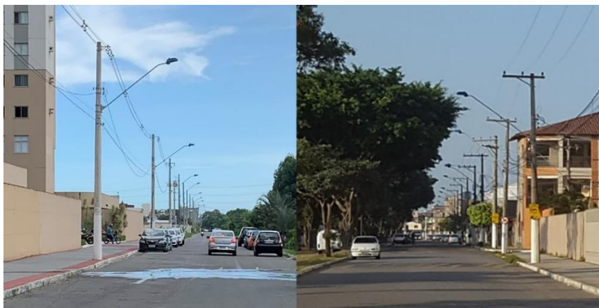
Figura 52 - Direcionamento dos postes, iluminando exclusivamente as vias.
